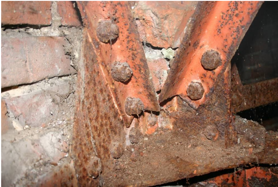
Rys. 42. Korozja węzła podporowego iglicy
