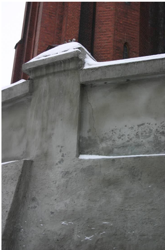
Rys 25. Ściana oporowa nasypu. Widoczne ślady pęknięć i wzmacniania dołu ściany.
