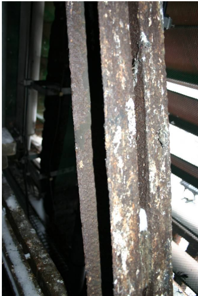
Rys. 41. Uszkodzenia korozyjne ramy stelaża od strony południowej
