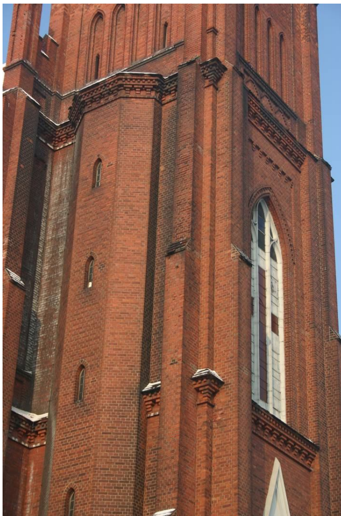
Rys 3. Przybudówka szybu komunikacyjnego od str. południowej. Powyżej widoczne blendy w elewacji.
