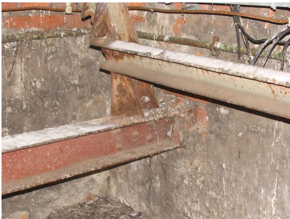
Rys. 16. Oparcie stelaża dzwonnicy na ścianie
