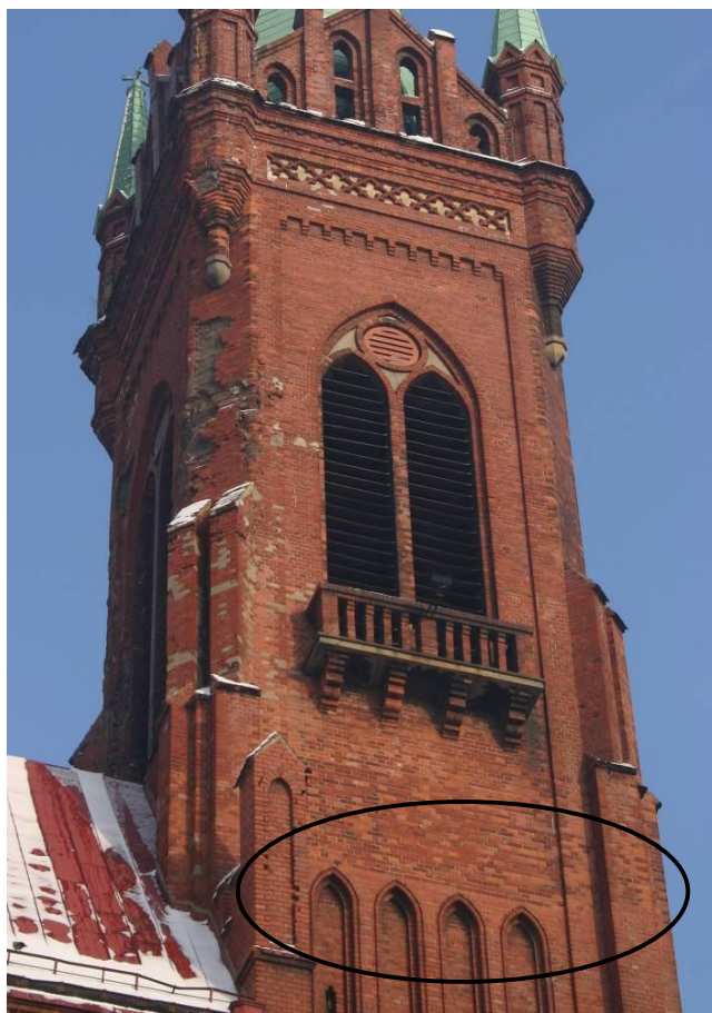
Rys.27. Południowa ściana dzwonnicy. Widoczne miejsce zmiany jakości elementów elewacyjnych oraz uszkodzenia elewacji od strony południowo-zachodniej
