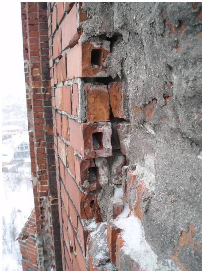
Rys.29. Odspojone i pęknięte cegły elewacyjne oraz cegła przewiązująca warstwę elewacyjną z warstwą nośną. Widoczne powierzchowne zabezpieczenie zaprawą na bazie cementu.
