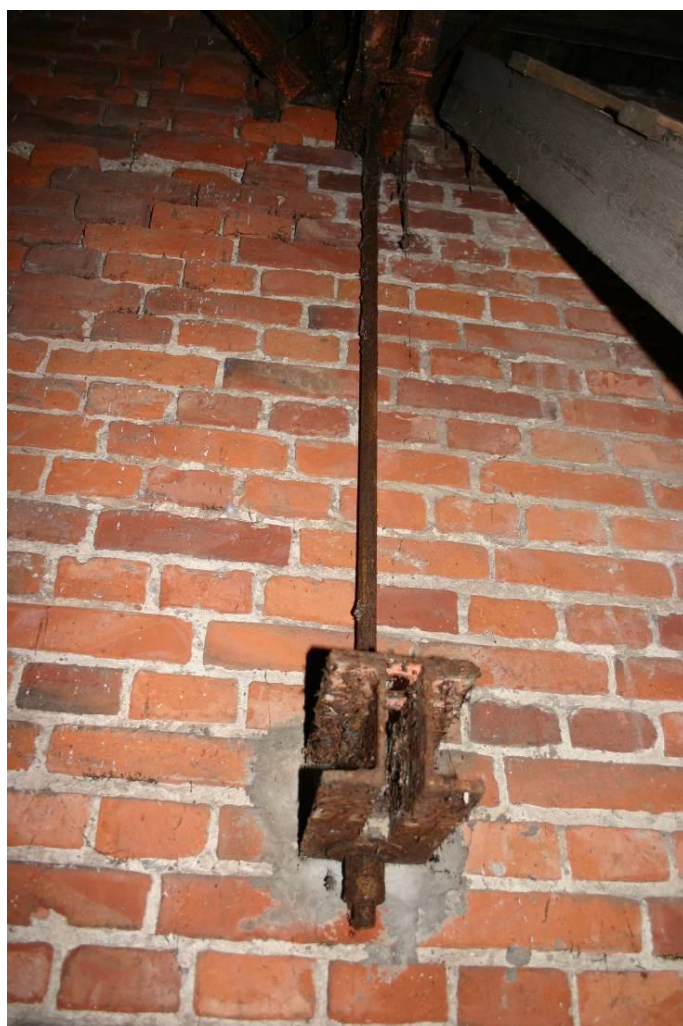
Rys. 19. Ściąg kotwiący iglicę w ścianie
