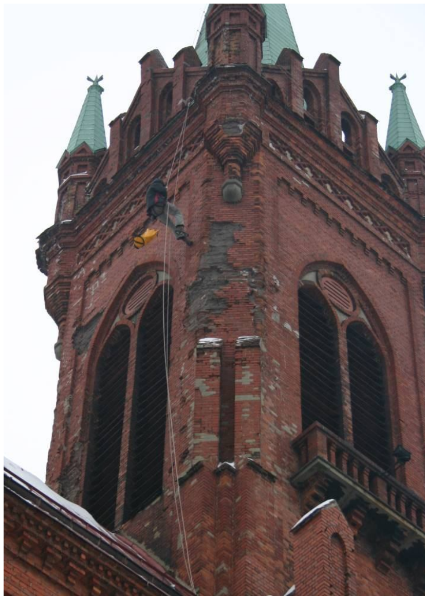
Rys.28. Uszkodzenia elewacji wieży od strony zachodniej
