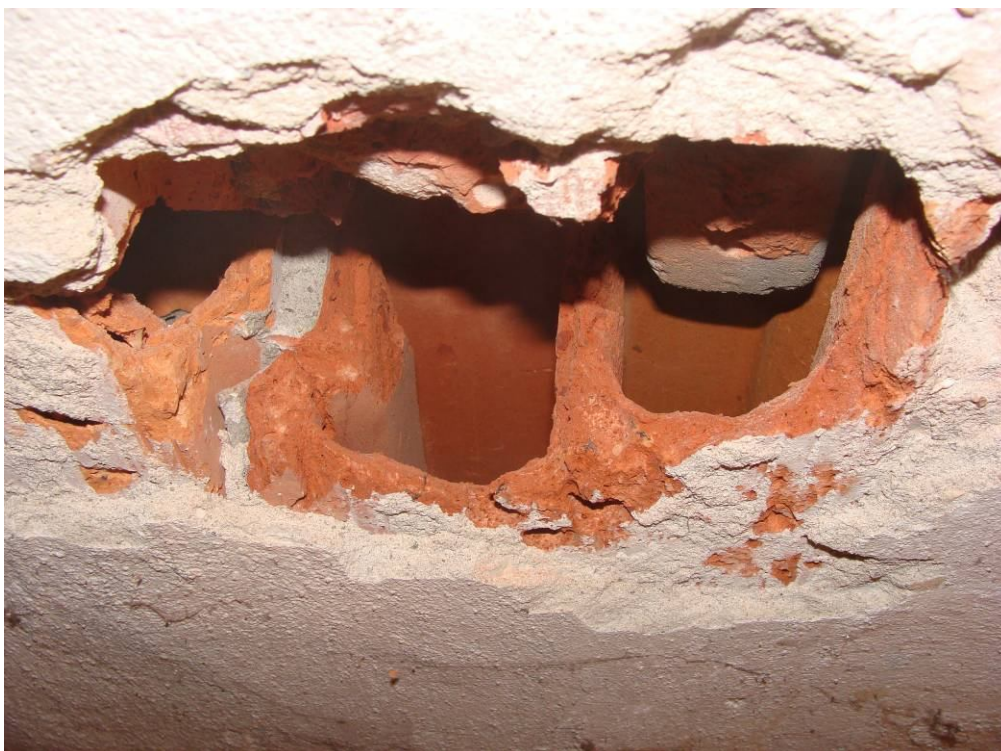
Rys 24. Fragment rozkutyh pustaków Foerstera. Z lewej strony widoczna spoina „pióro-wpust”.
