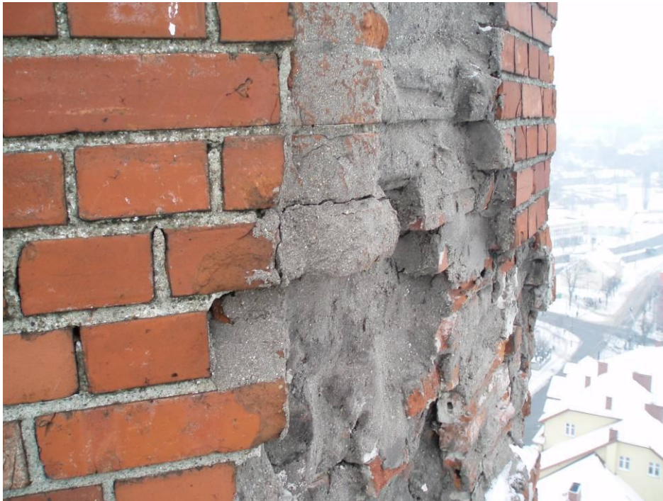
Rys.31. Uszkodzenia muru od strony południowo-zachodniej
