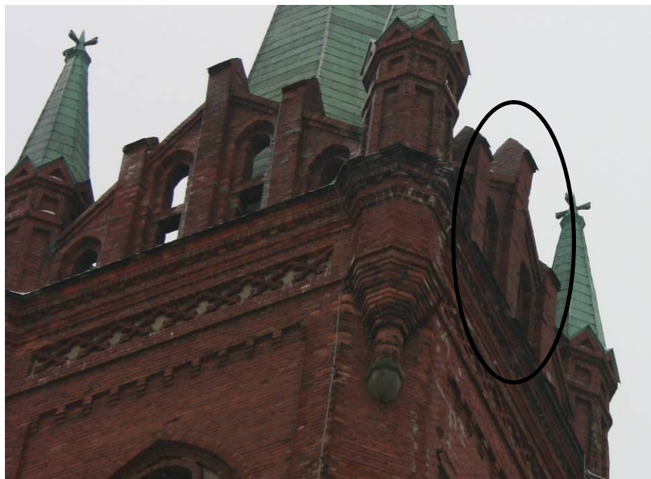
Rys.38. Wychylenie attyki od strony zachodniej
