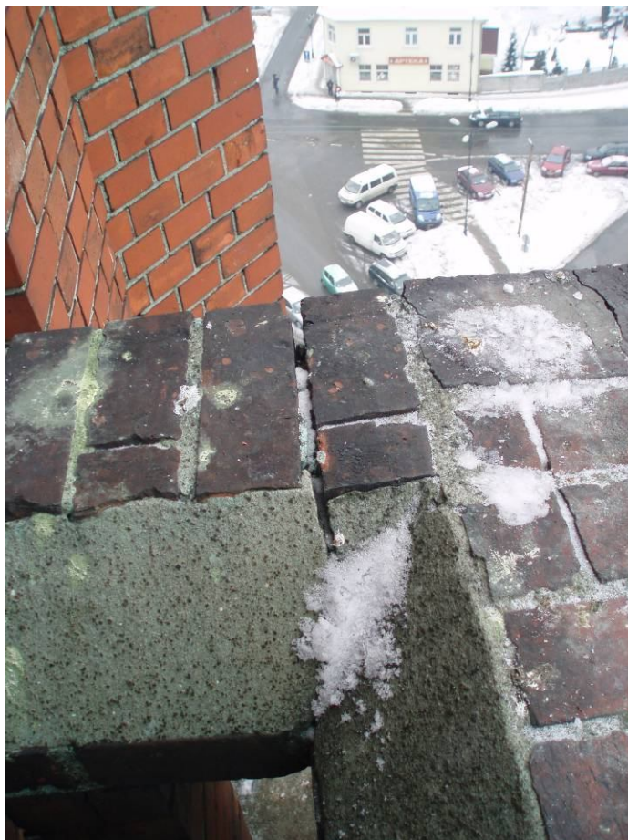
Rys.37. Uszkodzenia spoin balustrady od strony południowej
