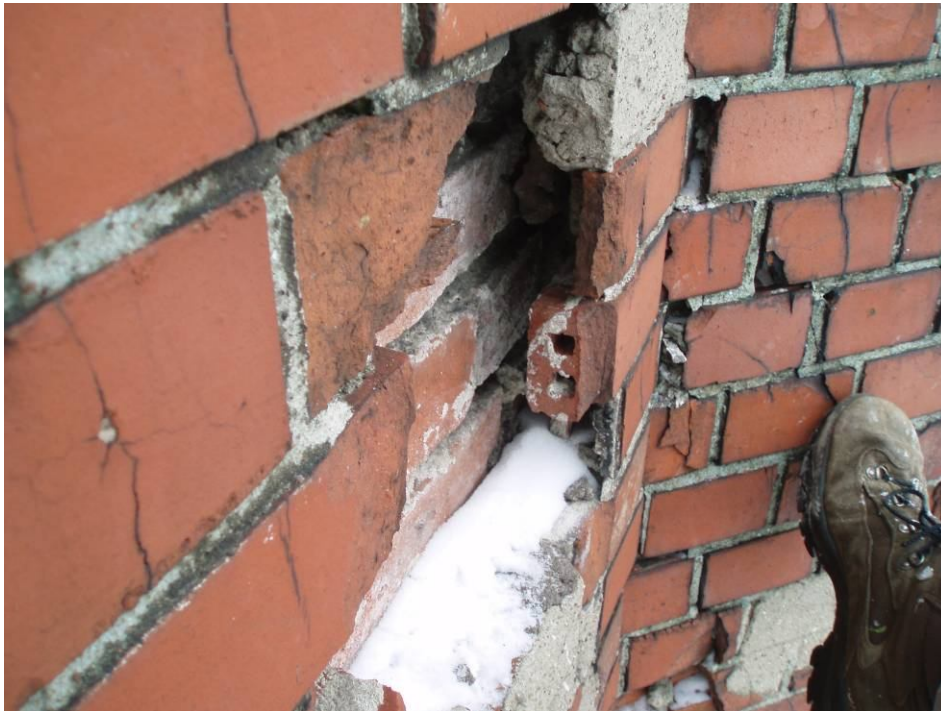
Rys.33. Uszkodzenia muru od strony południowo-zachodniej
