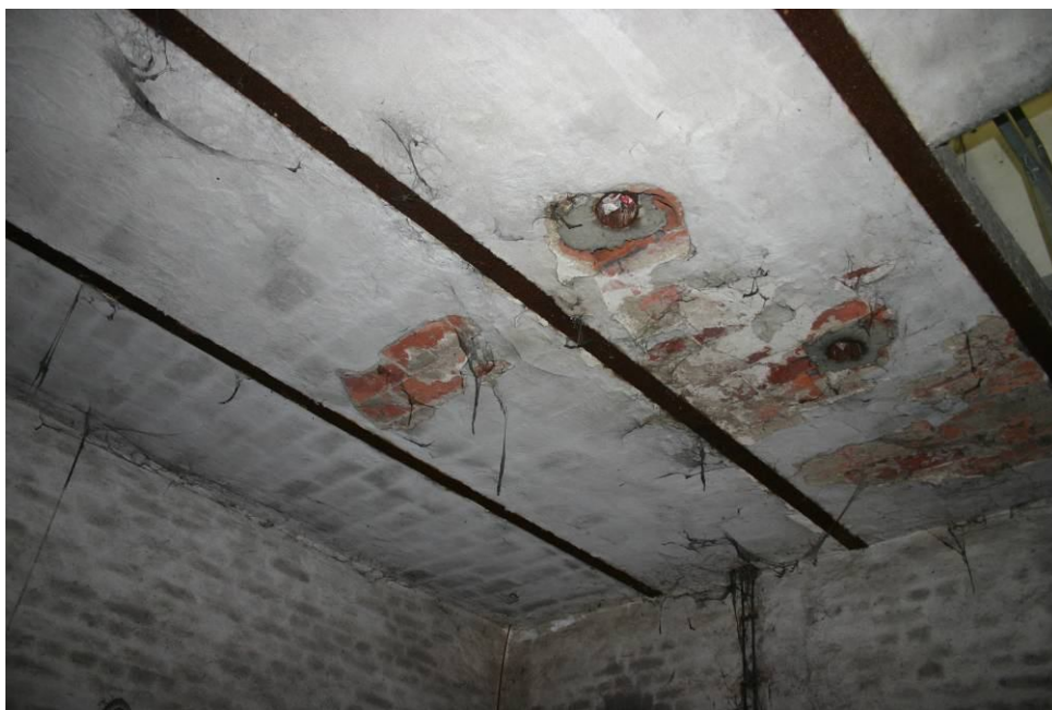
Rys.7. Strop stalowo-ceramiczny na poziomie 24.86. Widok od spodu
