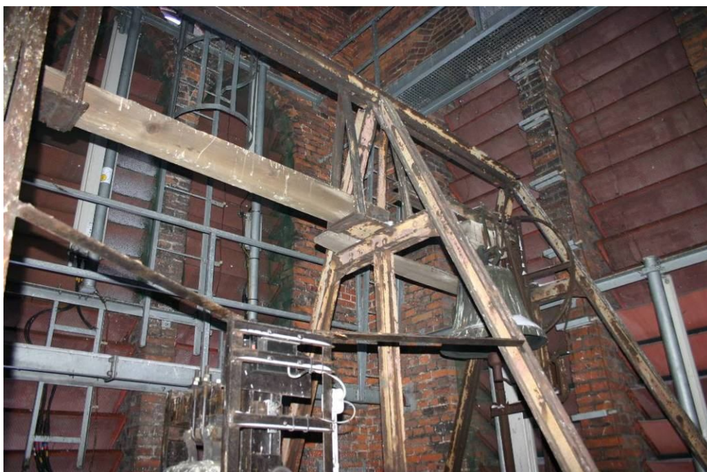
Rys.5. Stelaż dzwonnicy i pomosty stalowe w pomieszczeniu dzwonnicy
