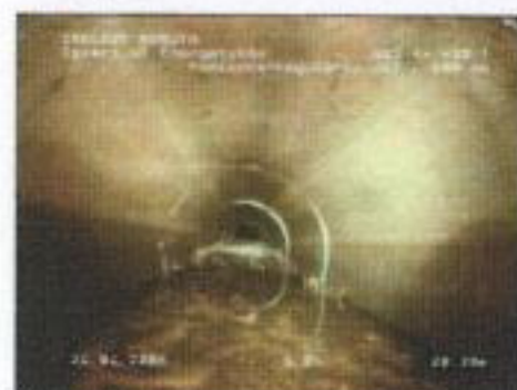
Nr sekcji: 1, Zdjęcie: 6a, Nr taśmy: , 00:00:00, Rezygnacja z inspekcji
