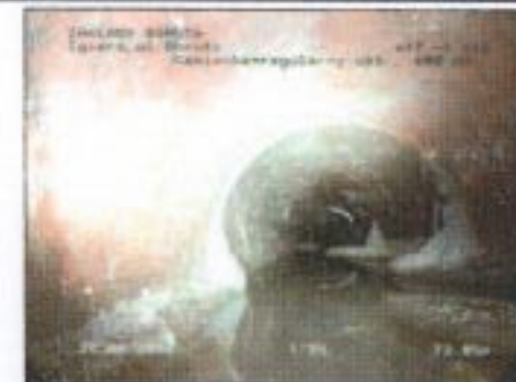
Nr sekcji: 7, Zdjęcie: 49a, Nr taśmy: , 00:00:00, Rezygnacja z Inspekcji
