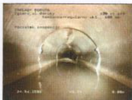
Nr sekcji: 4, Zdjęcie: 38a, Nr taśmy: , 00:00:00, Początek inspekcji
