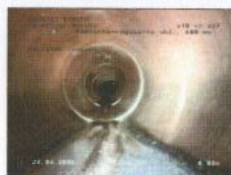
Nr sekcji: 6, Zdjęcie: 43a, Nr taśmy: , 00:00:00, Początek inspekcji
