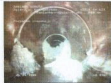
Nr sekcji: 18, Zdjęcie: 147a, Nr taśmy: , 00:00:00, Początek inspekcji
