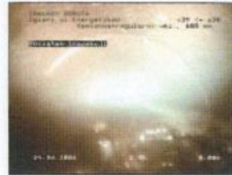
Nr sekcji: 19, Zdjęcie: 152a, Nr taśmy: , 00:00:00, Rezygnacja z inspekcji
