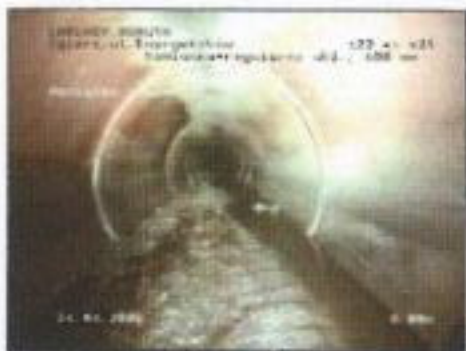
Nr sekcji: 2, Zdjęcie: 7a, Nr taśmy: , 00:00:00, Początek inspekcji
