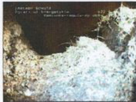
Nr sekcji: 18, Zdjęcie: 149a, Nr taśmy: , 00:00:00, Rezygnacja z inspekcji
