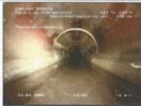
Nr sekcji: 1, Zdjęcie: 1a, Nr taśmy: , 00:00:00, Początek inspekcji
