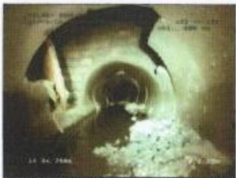
Nr sekcji: 2, Zdjęcie: 10b, Nr taśmy: , 00:00:00, Właz/węzeł
