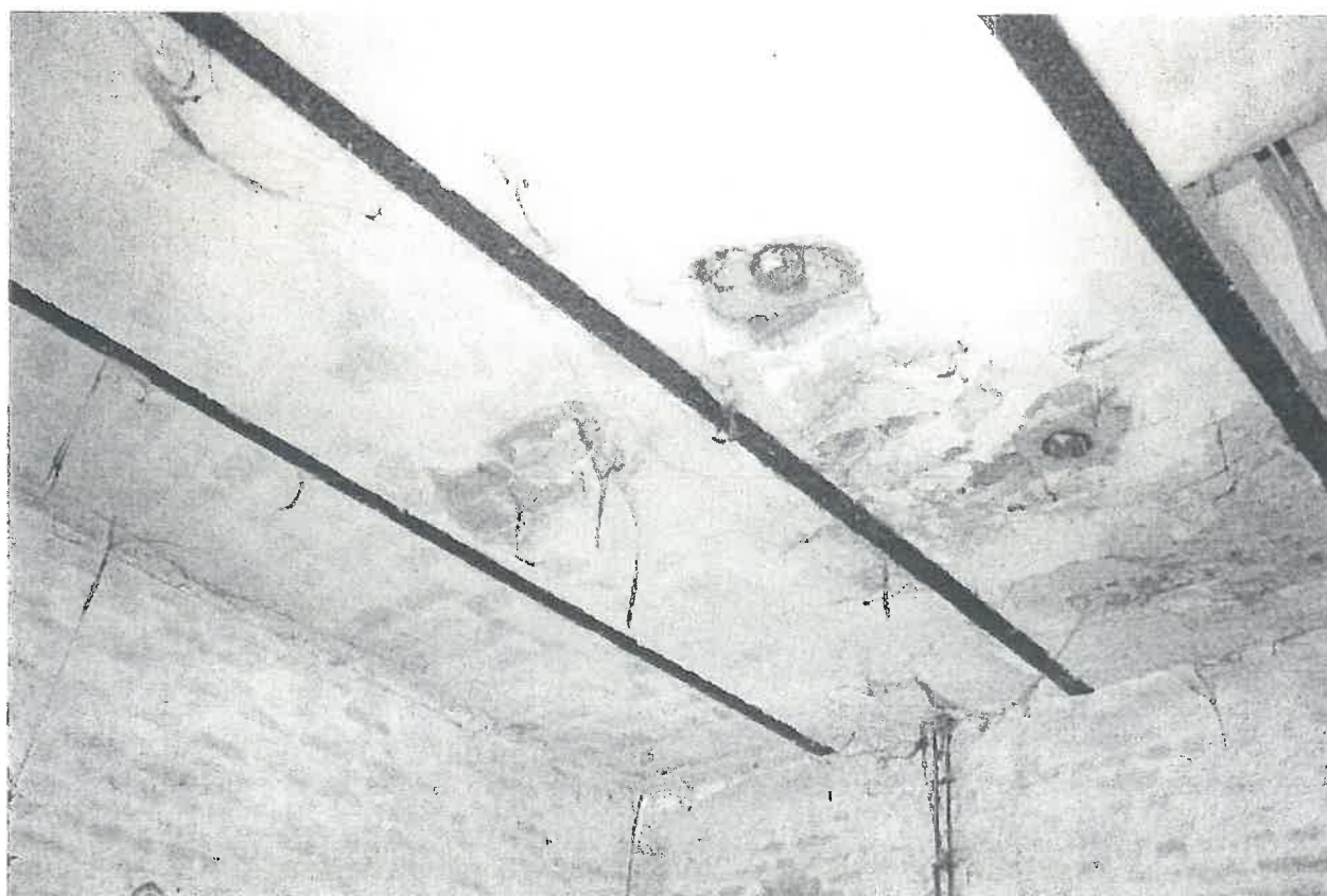
Fot.18 Strop pośredni stalowo-ceramiczny
