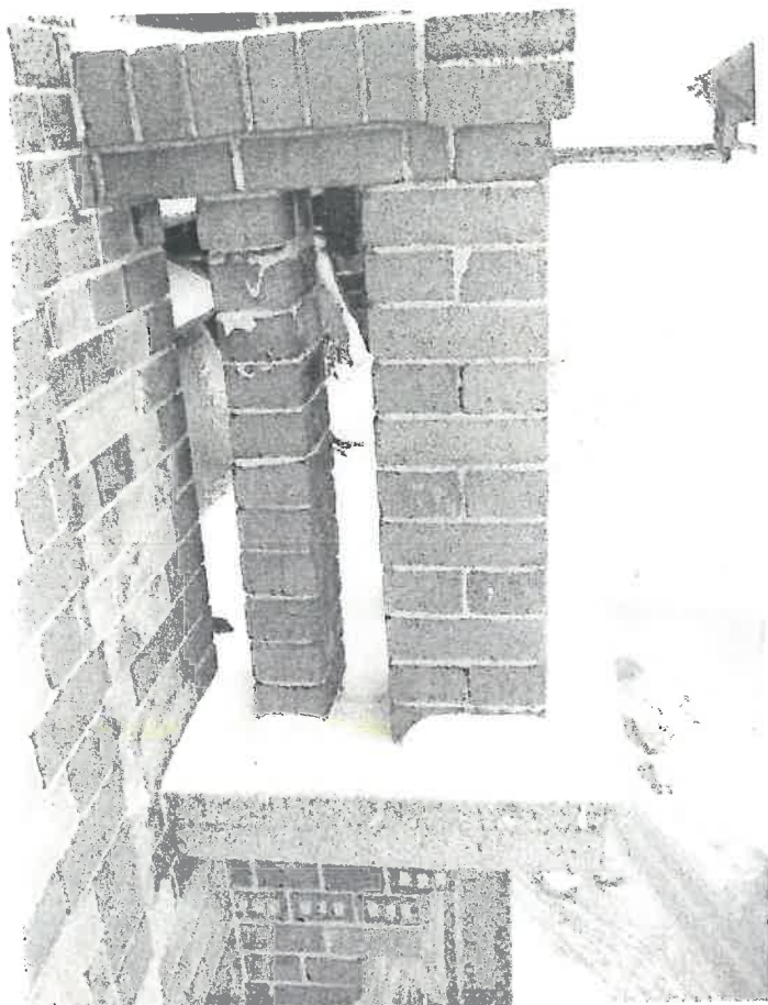
Fot.7 Balkon na elewacji południowej
