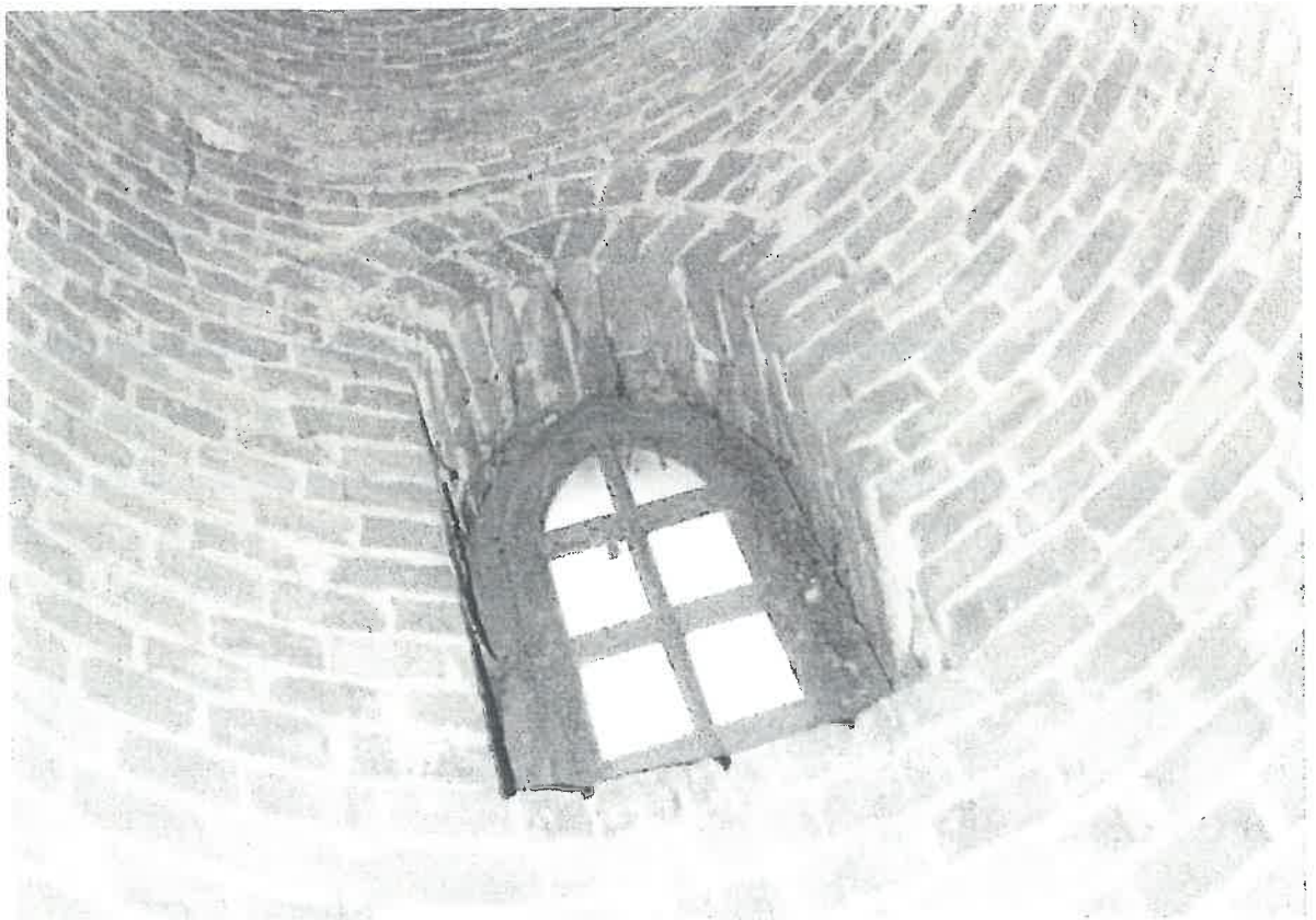
Fot.16 Okno w wieżyczce północnej
