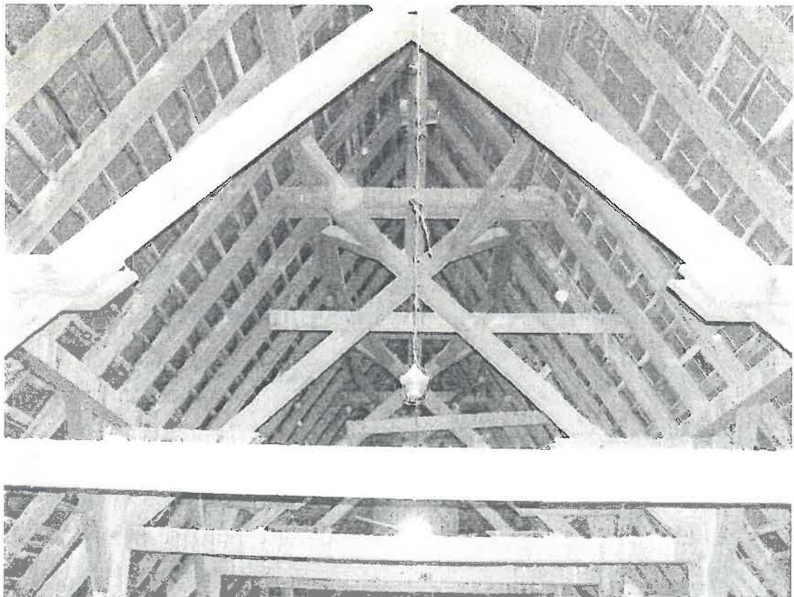
Fot.20 Wieszba nad nawą główną
