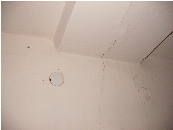
Fot.3 Pęknięcia tynku wewnętrznego na dylatacji Fot.4 Zarysowanie tynku zewnętrznego
