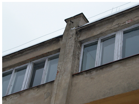
Fot.3 Pęknięcia tynku wewnętrznego na dylatacji Fot.4 Zarysowanie tynku zewnętrznego
