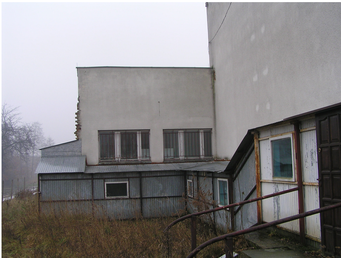
ŁĄCZNIK - WIDOK OD STRONY PÓŁNOCNEJ
