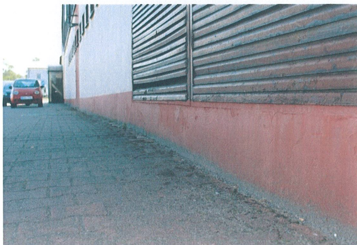
Fot. 7 Widok ściany zewnętrznej
