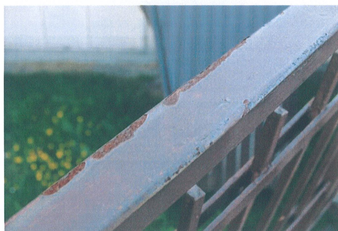
Fot. 5 Widok fragmentu balustrady
