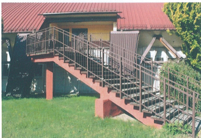
Fot. 1 Widok schodów - od strony wschodniej
