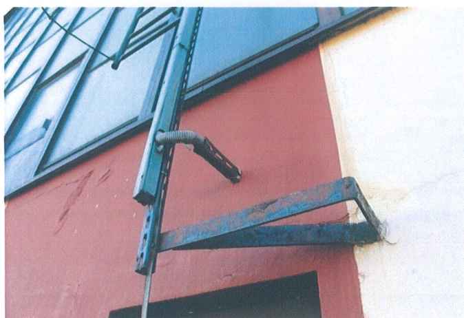
Fot. 9 Kotwienie drabiny
