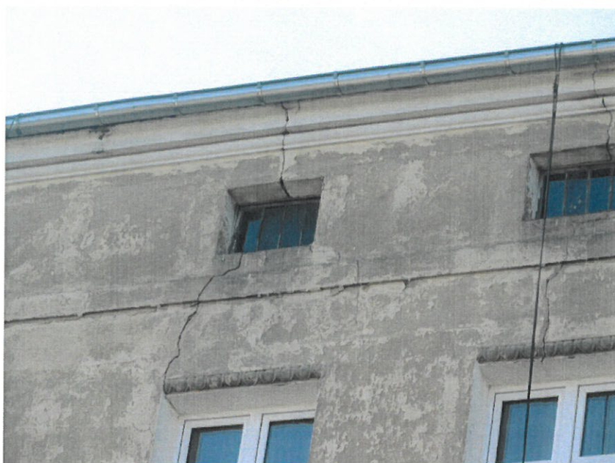
Pęknięcia ścian wywołane osiadaniem fundamentów i brakiem zwieńczenia
