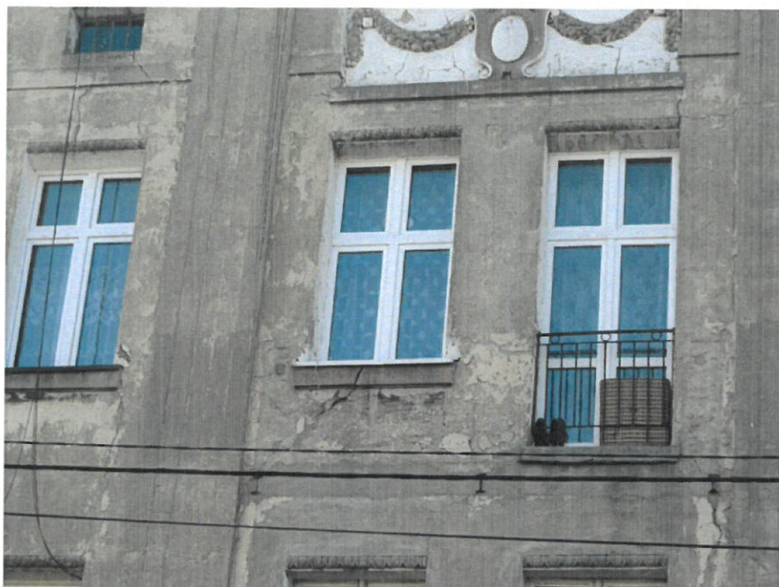
Pęknięcia ścian wywołane osiadaniem fundamentów i brakiem zwieńczenia
