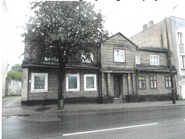
Budynek mieszkalno-usługowy w Zgierzu przy ul. Długiej 30
