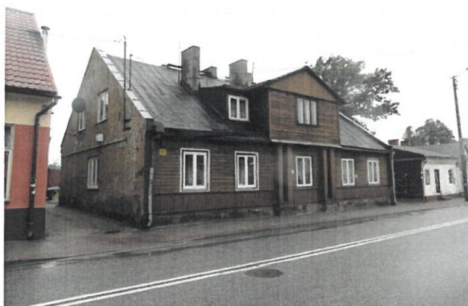
Budynek mieszkalno-usługowy w Zgierzu przy ul. Długiej 40
