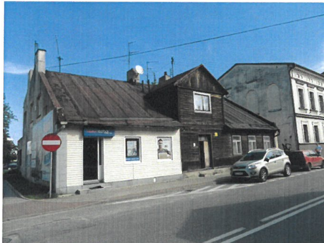
Budynek mieszkalno-usługowy w Zgierzu przy ul. Długiej 41
