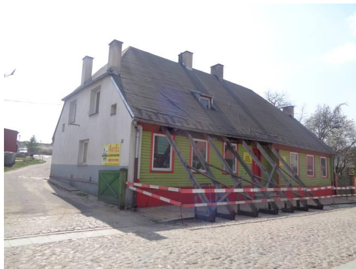
Zdjęcie 1. Elewacja frontowa budynku ul. Rembowskiego 2.
