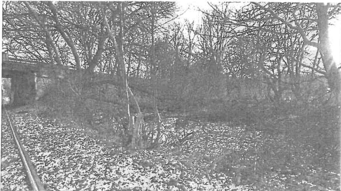
Fot. 9. Wilgotne zadrzewienia po północnej stronie wiaduktu.
