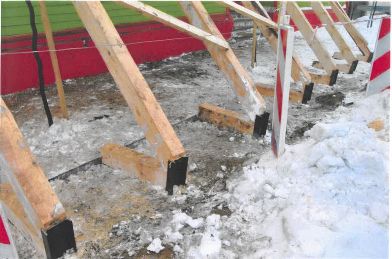
Zdj. nr 3. Szczegóły wykonanego podparcia krokwi dachowych.
