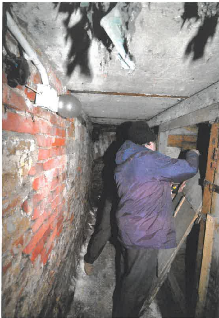
Zdj. nr 17. Ściany i strop podpiwniczenia.
