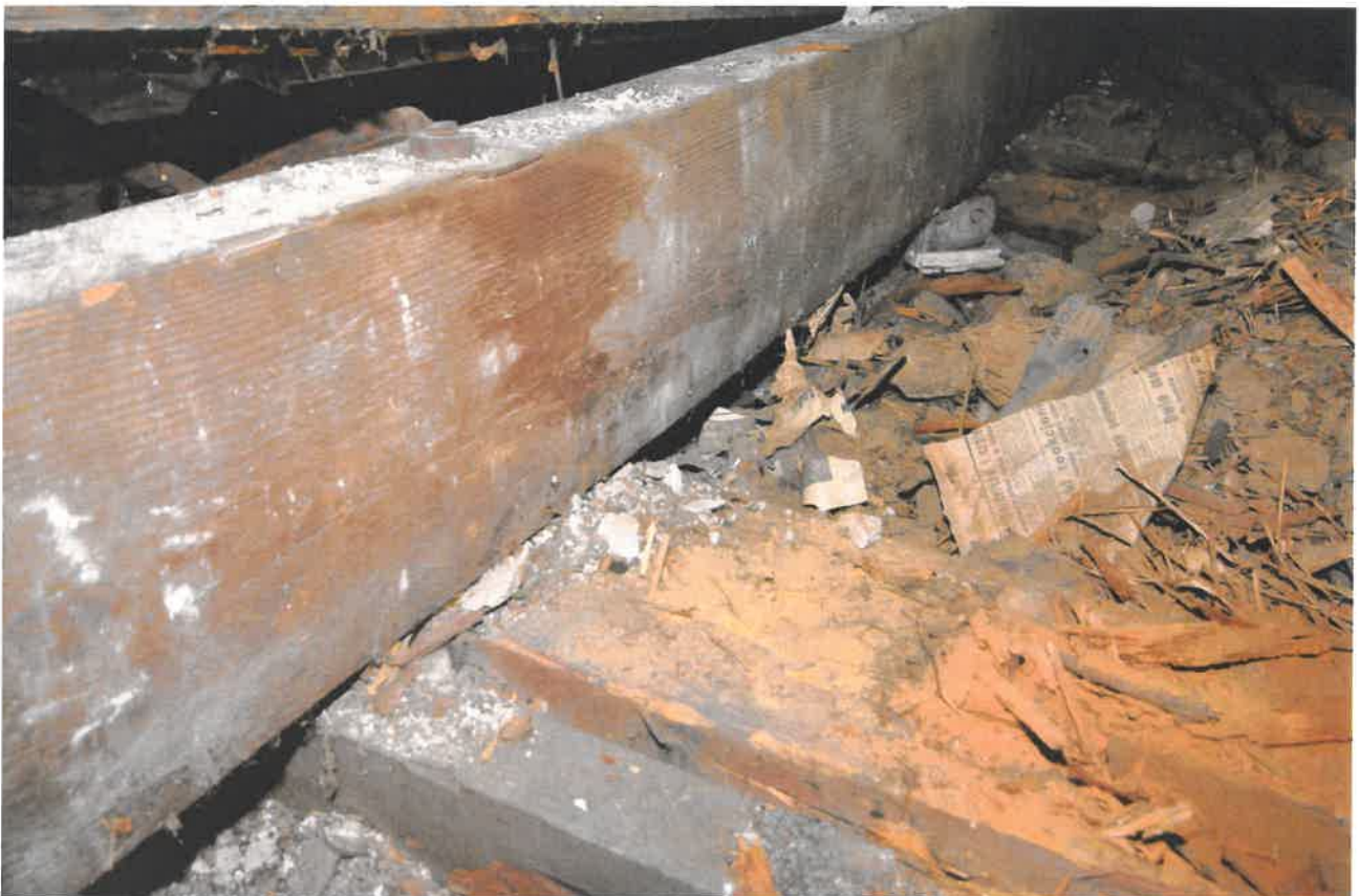
Zdj. nr 12. Podwieszenie belki stropowej.
