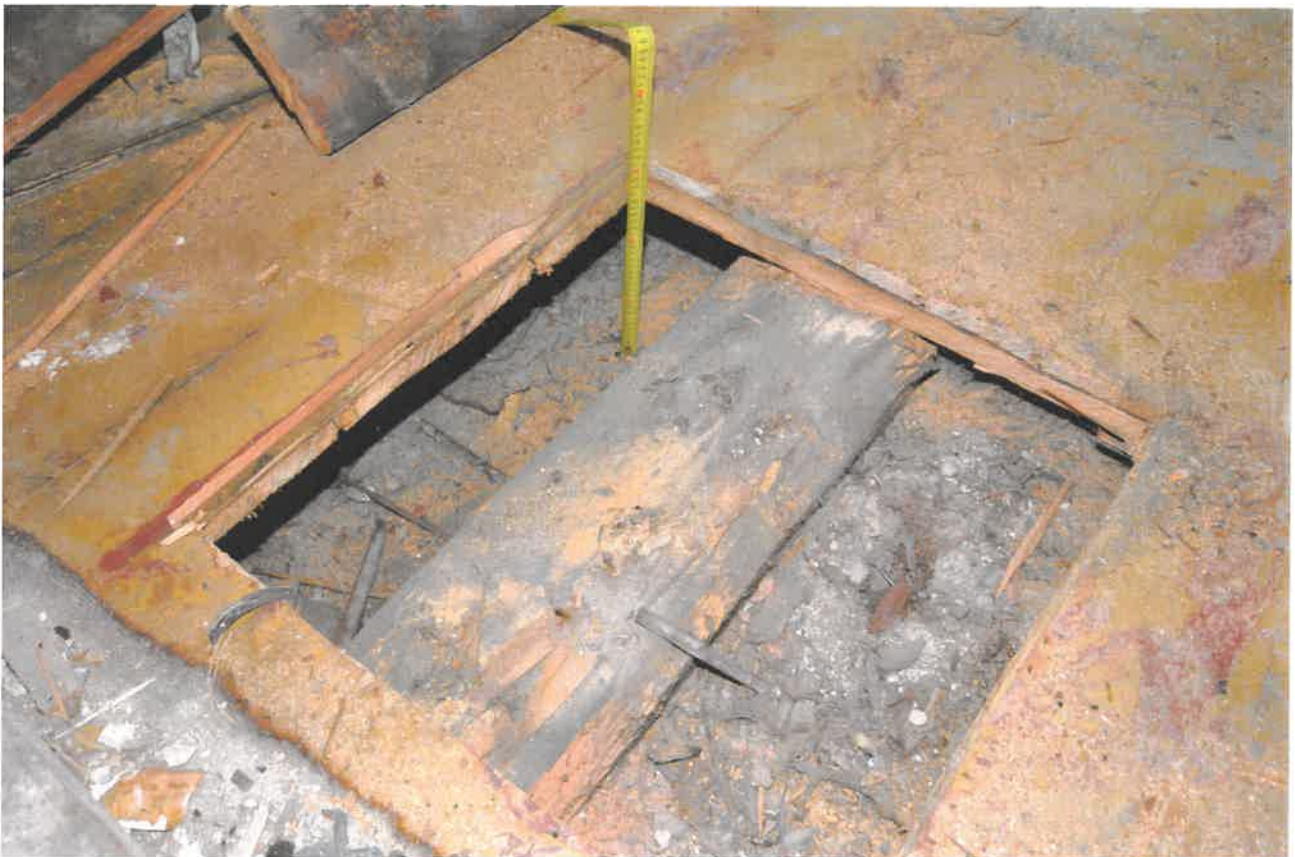
Zdj. nr 4. Odkrywka stropu.
