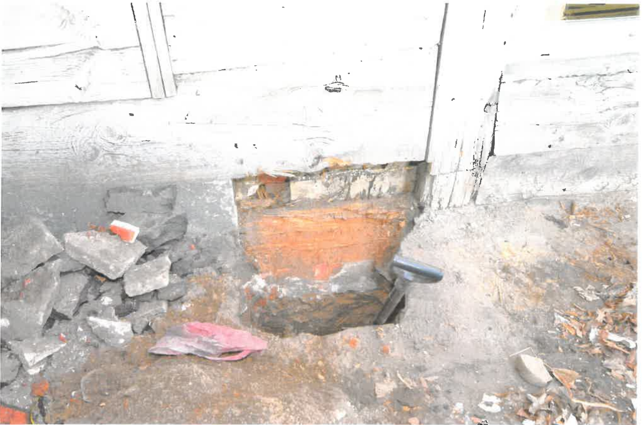
Zdj. nr 15. Odkrywka fundamentu i stan belki podwalinowej.
