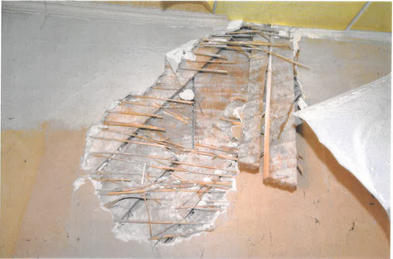
Zdj. nr 13. Ściana międzylokalowa.
