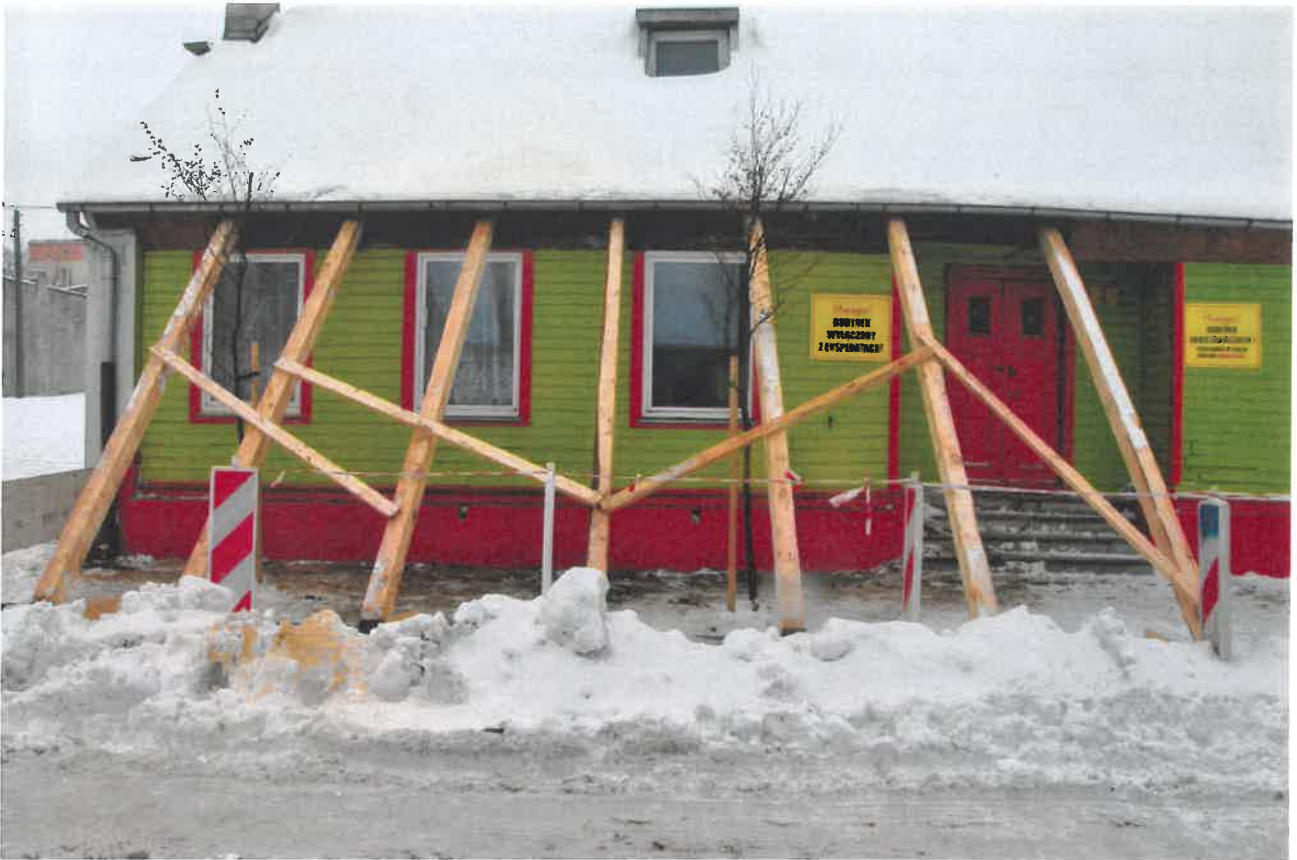
Zdj. nr 1 Widok frontu budynku (strona północna).
