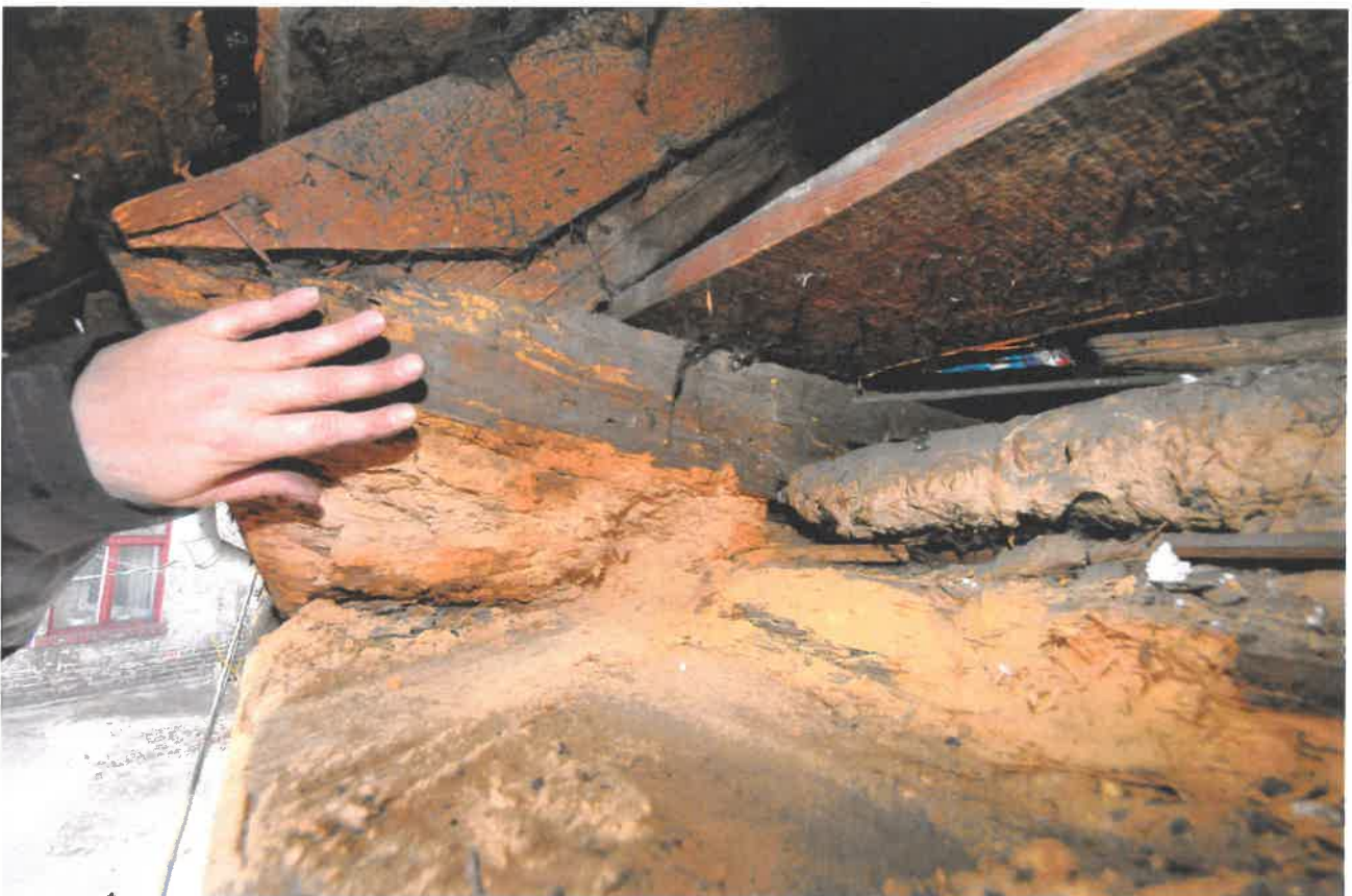
Zdj. nr 16. Odkrywka belki oczepowej i końcówki belki stropowej.
