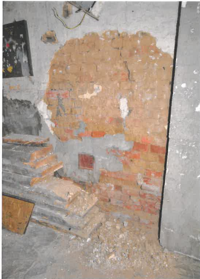
Zdj. nr 14. Ściana komina.
