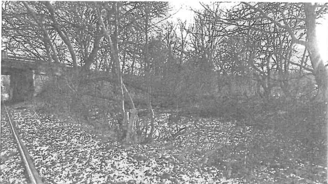
Fot. 9. Wilgotne zadrzewienia po północnej stronie wiaduktu.
