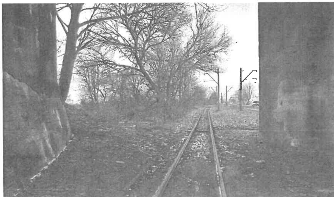
Fot. 7. Wiadukt kolejowy nad torami tramwajowymi.
