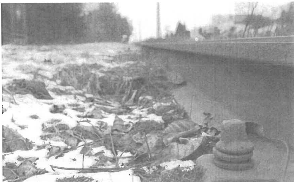
Fot. 15. Wysoka krawędź szyny tramwajowej – bariera dla małych zwierząt.
