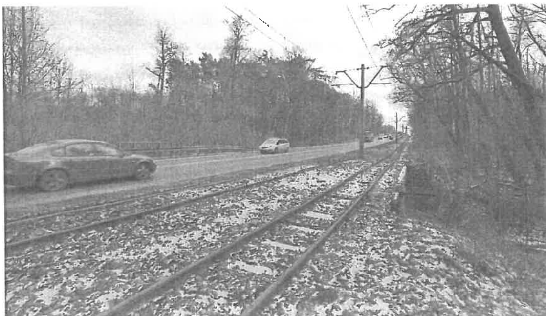
Fot. 1. Fragment linii tramwajowej na wysokości mostu na Wrzącej
