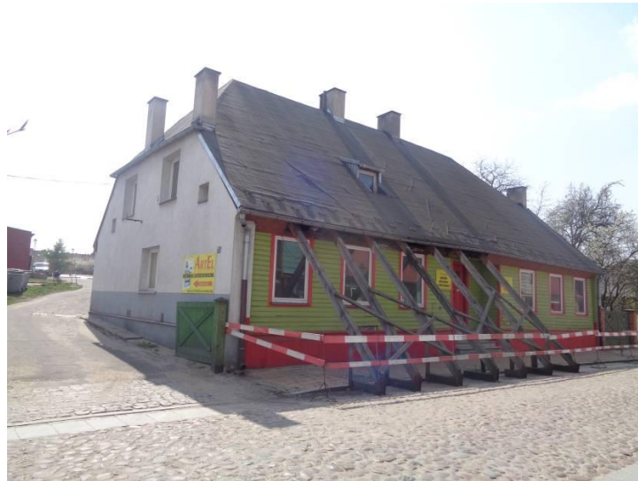
Zdjęcie 1. Elewacja frontowa budynku ul. Rembowskiego 2.
