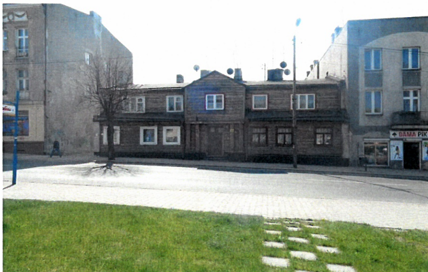
FOT 8 - Budynek przy u. Długiej 30 (fot. własna)
