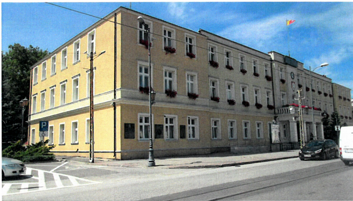
FOT 1 – Budynek Urzędu Miasta Zgierza (fot. własna)
